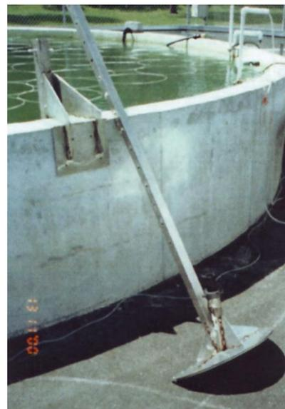
Figure 20. Semi-circular diffuser
